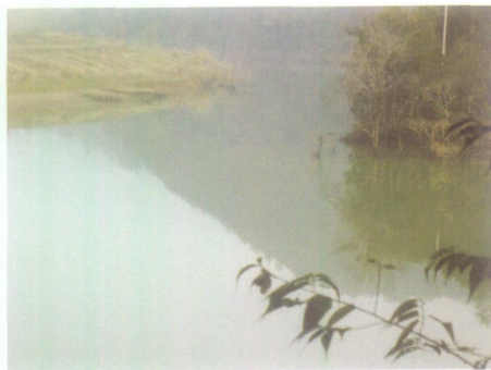
附图21 泽丰电站水库库岸已开始坍塌
