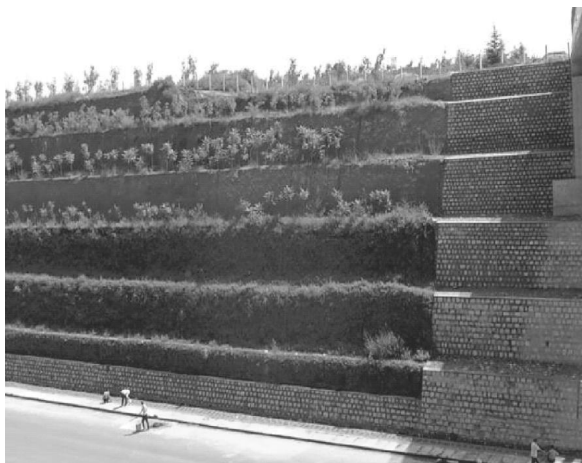
图 2 西禹高速公路 K173 段厚层基材喷播植草防护
