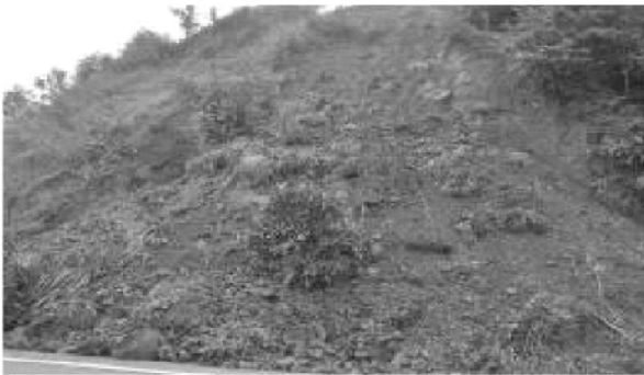
图 5 G213 一侧坡体的表层堆积体在降雨作用下的滑动
