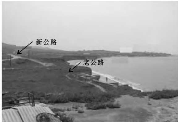
图 2 腾房身海岸侵蚀造成公路改道
