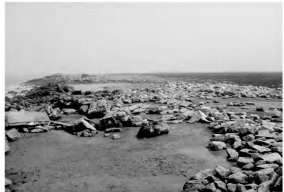
图 4 朱家屯外侧海岸侵蚀破坏情况
