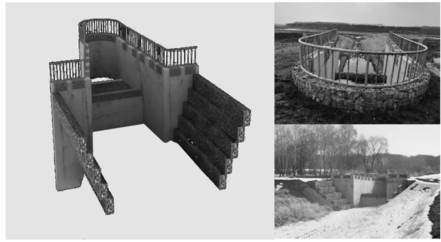
图 1 大型钢筋混凝土跌水三维模拟效果图(左)与实物照片(右)
