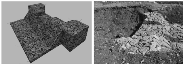
护耳坝体+宽溢流口+海漫石笼谷坊
