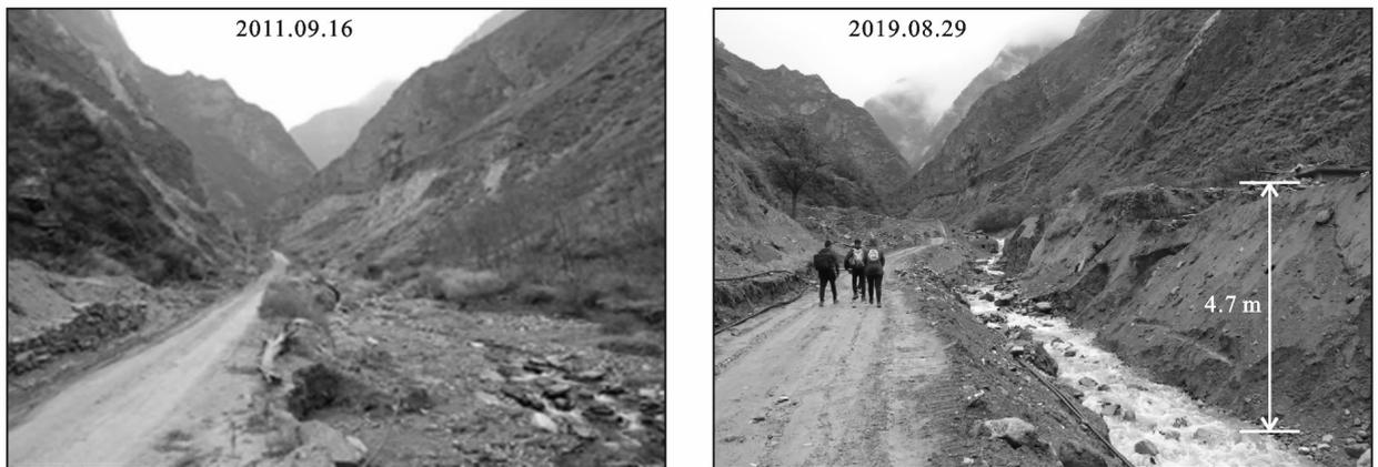
图3 下庄沟“8·20”泥石流侵蚀破坏
