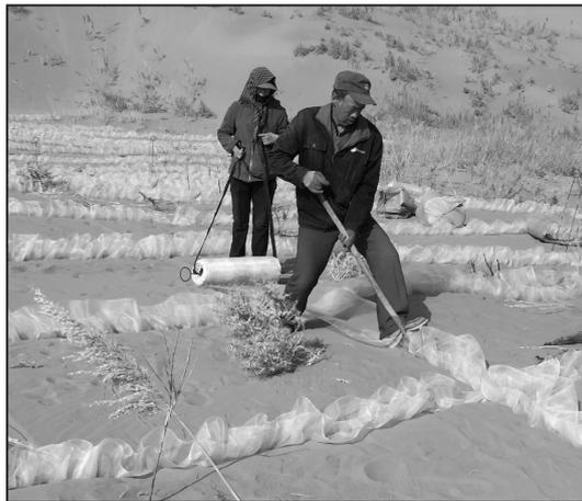
图 1 直压立式纱网沙障铺设工作
