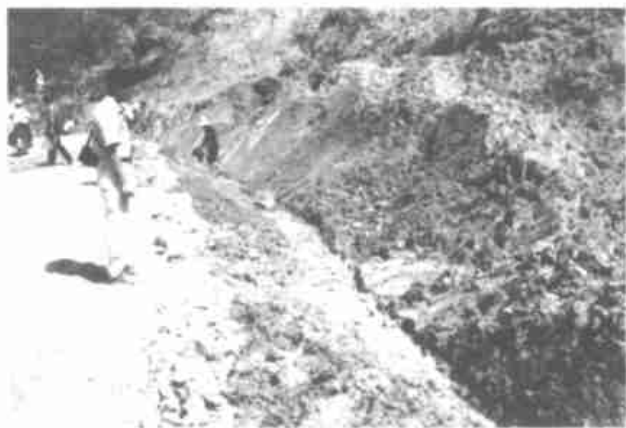
图 2 滑坡中后沿的饱和土体
