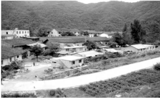
图 1 弃渣场利用——宅
