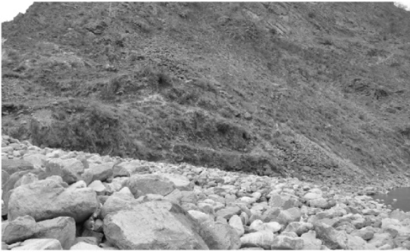
图 6 利子依达沟 III, VI 期泥石流断面结构
