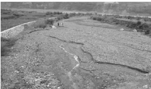
图 2 黑水河堆积扇沟道中的泥石流流体
