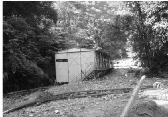
图2 泥石流堵塞隧道、冲毁施工板房
