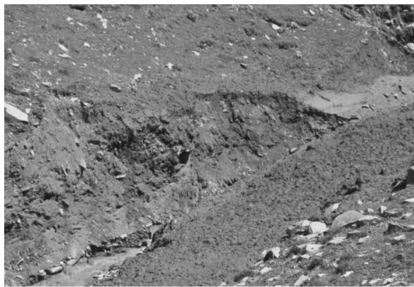
图5 泥石流沟道两侧“铲、刮”严重
