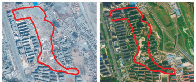
图 5 龙泉镇 6 号砂石坑影像对比
