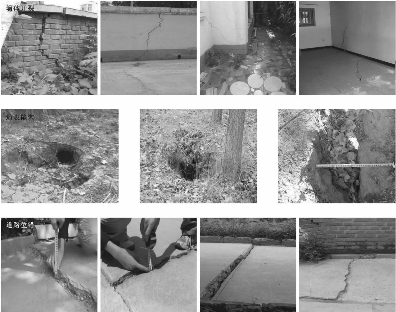
图 1 地裂缝活动造成的地表及建筑物破坏现象
