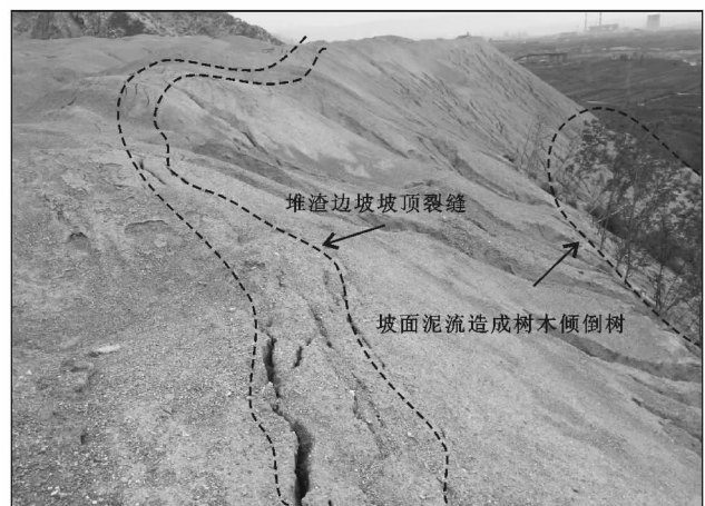
图 3 矿区渣堆边坡拉裂缝及局部崩塌
