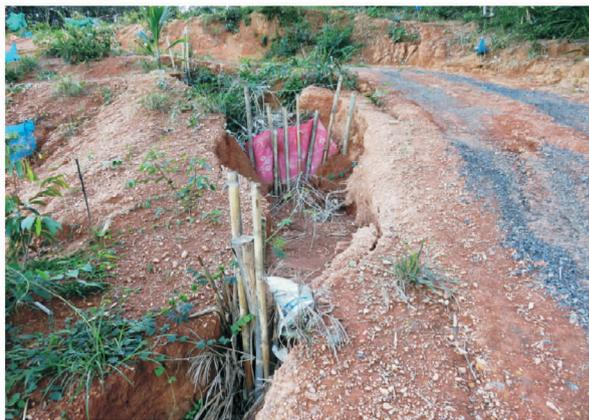
图 7 清莱府地区道路侵蚀防治措施(路面碎石硬化和小型谷坊修建,李玉茹摄于 20181125)
