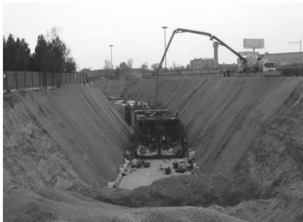
图 3 倒虹吸工程施工区外侧设铁质围挡、开挖边坡及临时堆土采取苫盖等措施
