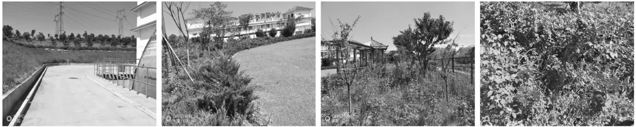
图7 南水北调中线河南段郑州须水河倒虹吸顶部小型休闲生态园的部分景观
