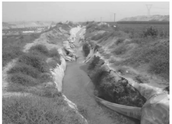
图 2 倒虹吸施工区表土临时拦挡、防尘网苫盖(左)与外侧排水沟防渗等措施现场
