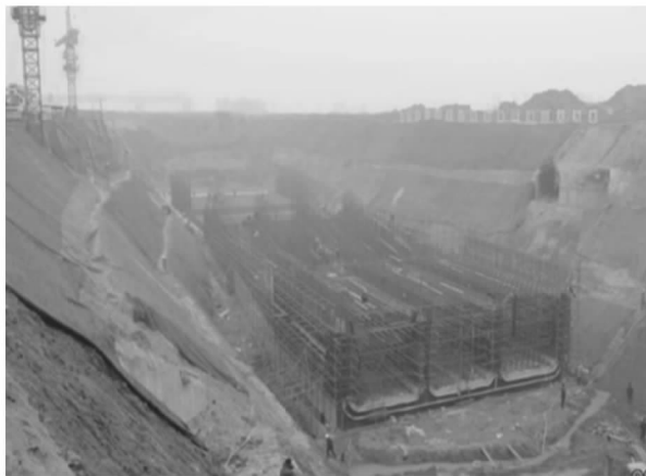
图 3 倒虹吸工程施工区外侧设铁质围挡、开挖边坡及临时堆土采取苫盖等措施
