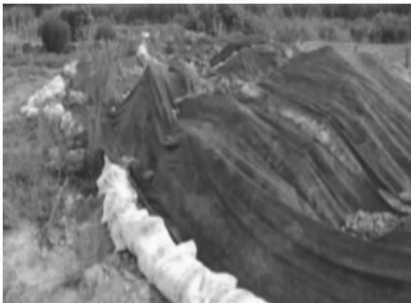
图 2 倒虹吸施工区表土临时拦挡、防尘网苫盖(左)与外侧排水沟防渗等措施现场
