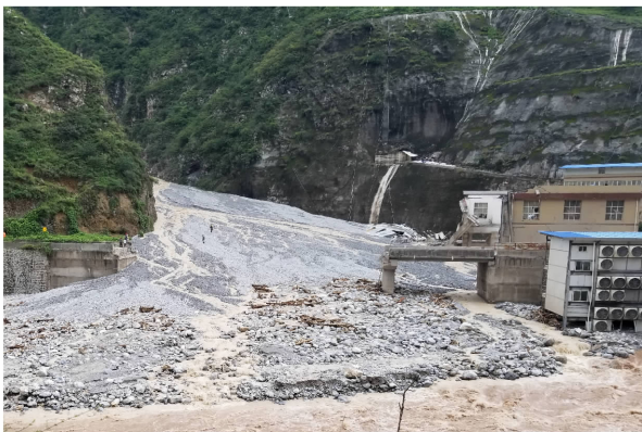
图4 山洪泥石流进入主河道时典型泥沙淤积致灾情况
