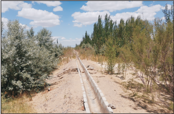
a 格尔木市大格勒乡灌溉渠跑漏水导致的侵蚀沟(焦菊英摄于20190719)
