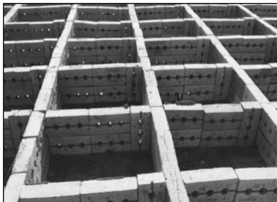
图 8 固沙砖沙障的铺设形式
