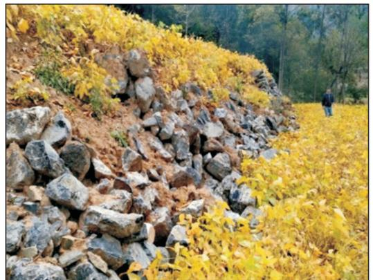
图 2 土-砼复合体边坡与同期石坎边坡损毁对比
