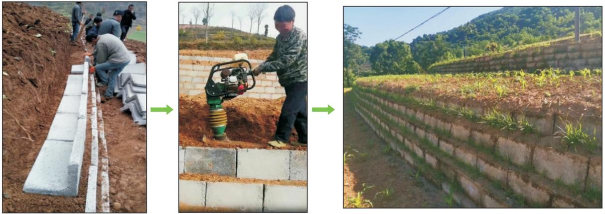
图 1 构件安装、回填夯实和建成试验田
